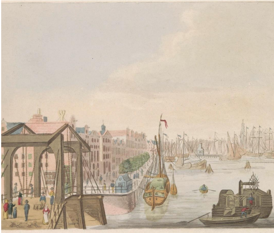
Afb. 6: Evert Maaskamp. Gezicht op de Buitenkant (nu Prins Hendrikkade) en het IJ, gezien vanaf de brug naar Kattenburg te Amsterdam, ca. 1810-1813. Onderdeel van een plaatwerk uit ca. 1824-1825 met 74 (ongenummerde) platen van de belangrijkste topografische gezichten en verschillende zeden en gewoonten in het Verenigd Koninkrijk der Nederlanden. Ets, aquatint en gravure, met de hand gekleurd, 201 mm × 235 mm. Rijksmuseum Amsterdam, objectnr. BI-B-FM-116-16, Het pand Prins Hendrikkade 144 heeft een halsgevel en er zijn op dit werk inderdaad enige panden met halsgevels te zien.
